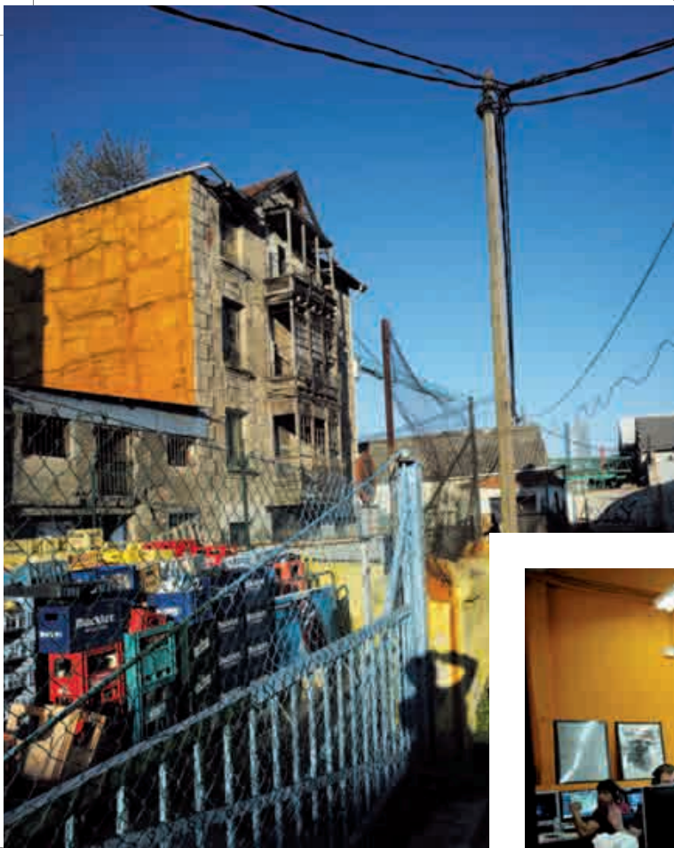
Zorrotzaurre est une immense friche où résident encore 470 habitants. Ci-dessus, le vaste hangar de la Papelera en cours de dépollution. En bas, Arturo Mondero, dirigeant de la société de création de jeux vidéo Delirium Studios
