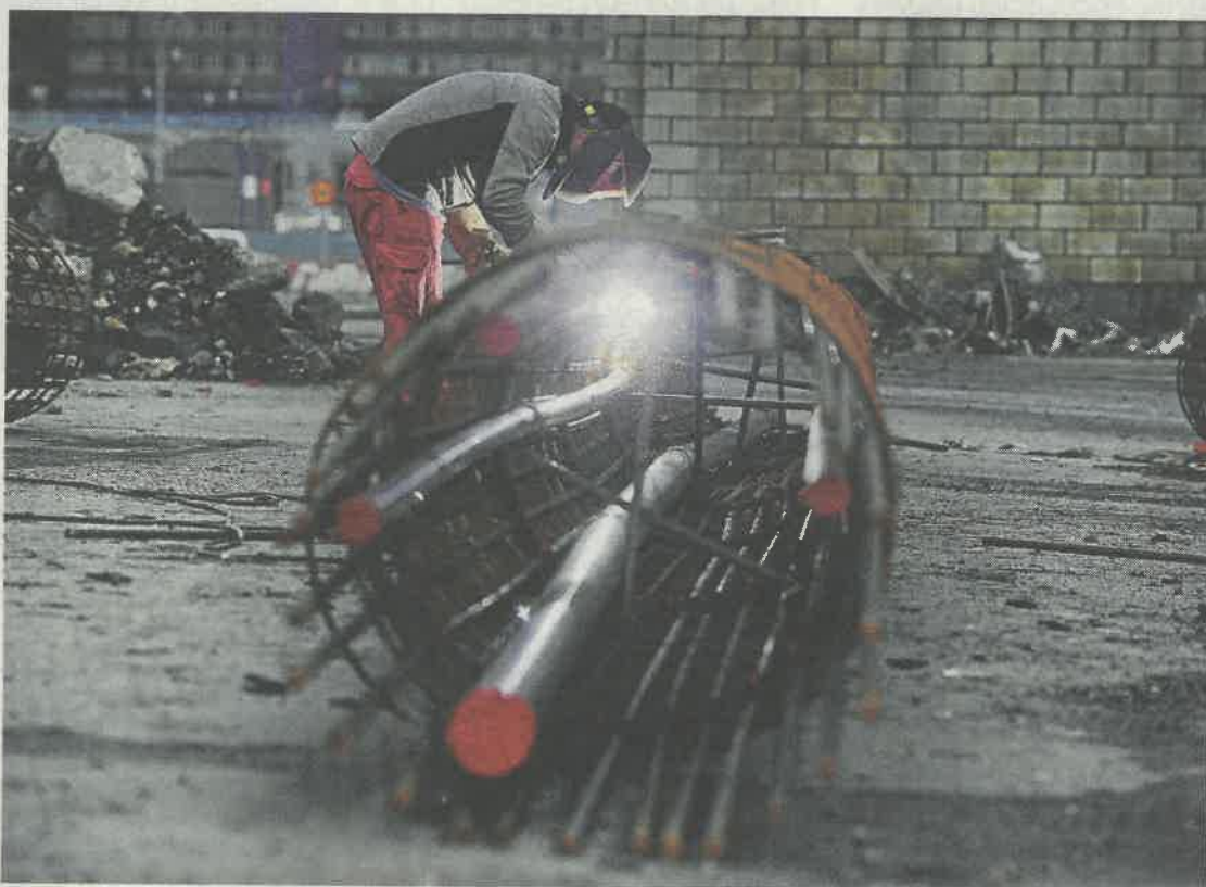
Imágenes de las tareas de pilotaje para afianzar el terreno antes de la excavación.
